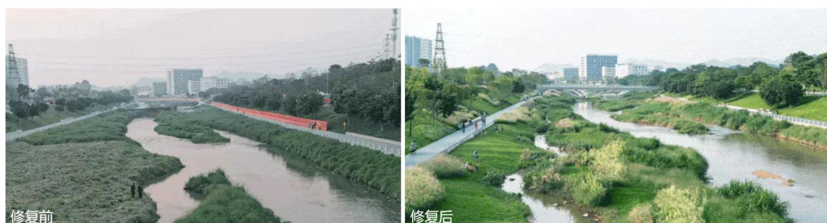
图 3-3 河道生态修复治理成效
